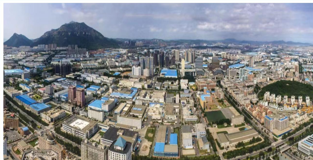
建成 建設完了
